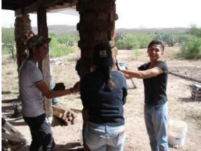
Figura 6 Consolidación de columnas en el porche.
