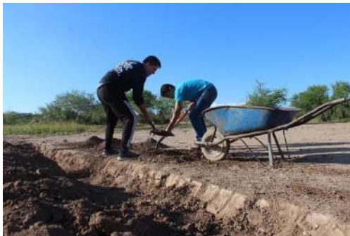
Figura 1: Extracción de material evitando la capa superficial para evitar contaminantes.
