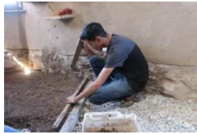
Figura 9. Proceso de compactación.
