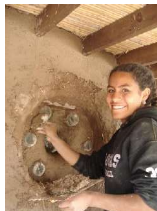
Figura 4. Aplicación de acabado de tierra, utilizando espátula plástica que facilita el detalle en redondeo.
