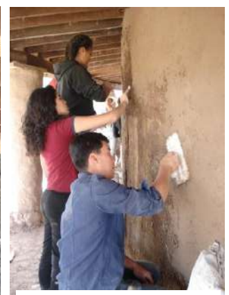
Figura 5. Uso de llana para grandes superficies.
