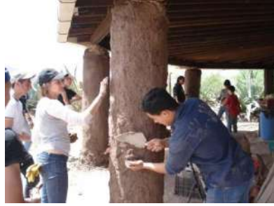
Figura 7 Uso de herramientas así como las manos para aplicación de la mezcla.
