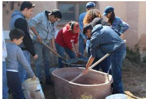
Figura 2: Elaboración de la mezcla para la capa del piso que se aplica sobre el lecho de grava gruesa.
