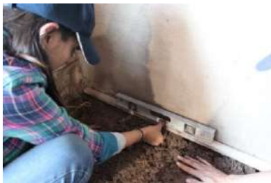
Figura 8 Nivelando la capa de tierra, paja, arena.
