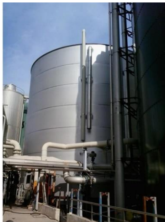
Figura 5. Tanque de almacenamiento de aguas residuales elaborado de acero inoxidable dúplex
