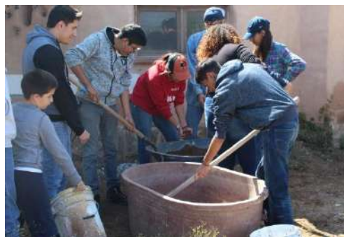
Figura 2: Elaboración de la mezcla para la capa del piso que se aplica sobre el lecho de grava gruesa.
