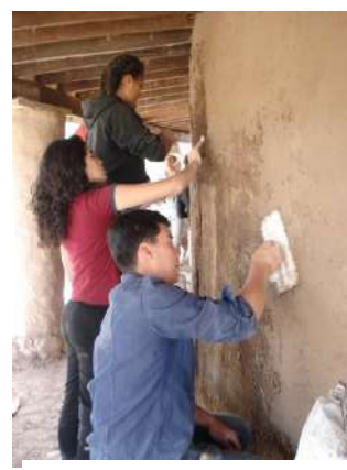
Figura 5. Uso de llana para grandes superficies.
