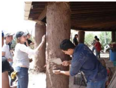
Figura 7 Uso de herramientas así como las manos para aplicación de la mezcla.
