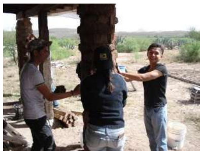
Figura 6 Consolidación de columnas en el porche.
