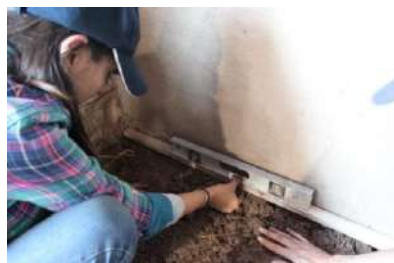
Figura 8 Nivelando la capa de tierra, paja, arena.
