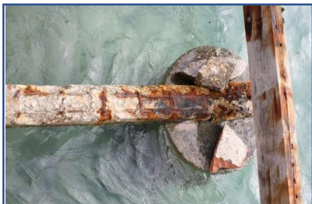
Figura 2. Efectos nocivos del ataque por agentes agresivos (cloruros y sulfatos) en el concreto convencional.
