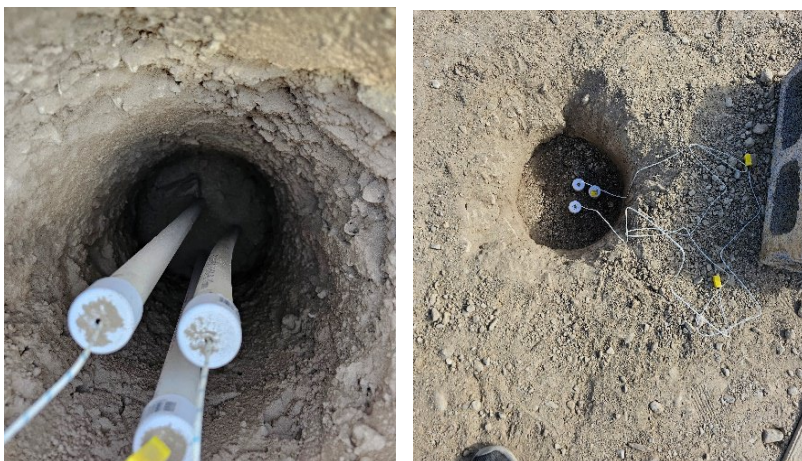
Figura 6. Instalación de termopares.
