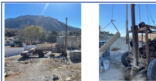
Figura 5. Excavadora de percusión a cable.
